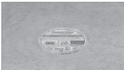
Pour Concrete Flush with Plug
